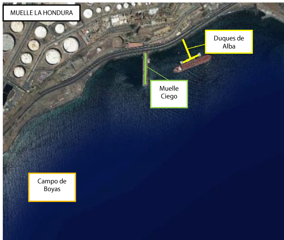
Ilustración 2. Diques, contradiques y muelles. Muelle La Hondura
