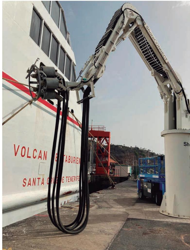
en los puertos de El Hierro y La Gomera. Con una potencia máxima de 20Kw cubrirá parte de la demanda de electricidad de instalaciones como las estaciones marítimas, el alumbrado y las instalaciones auxiliares.
